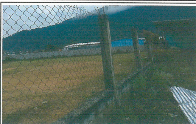
Foto 2: Remozamiento de cerco o Muro Perimetral
