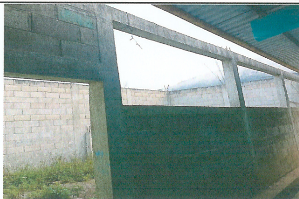
Foto 1: Remozamiento General de aula.
